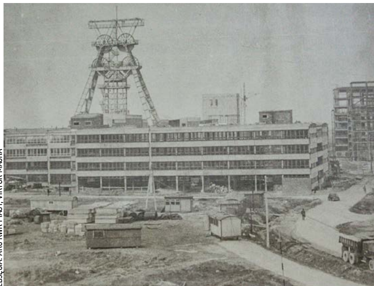
Zaawansowane roboty na obiektach zakładu.
