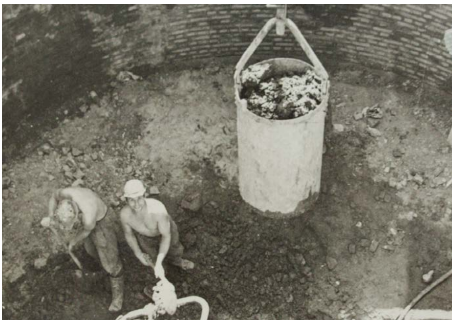
Głębinowanie szybu w obszarze górniczym Bieruń.
