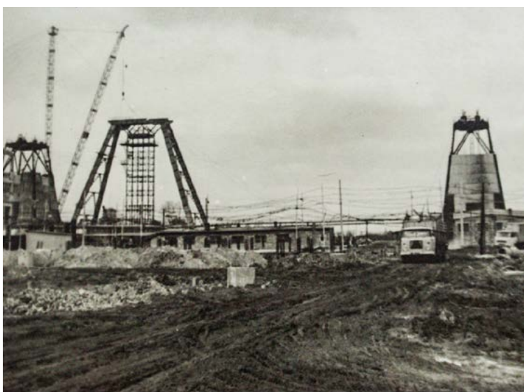
Głębinowanie szybów nr I i II przy pomocy wieży i urządzeń tymczasowych oraz fragment scalania wieży szyb I na miejscu zastępczym.
