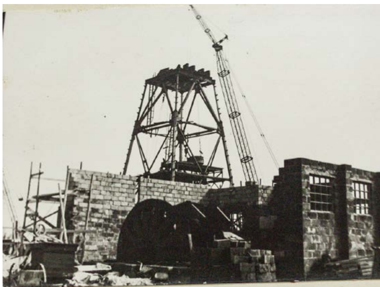
Budowa obiektów tymczasowych do głębinowania szybów, maszyna wyciągowa.
